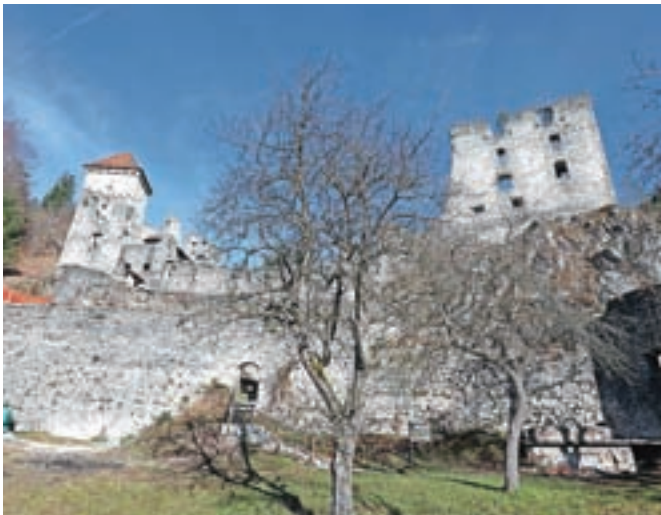
Na gradu Kamen potekajo vzdrževalna dela. / FOTO: GORAZD KAVČIČ
